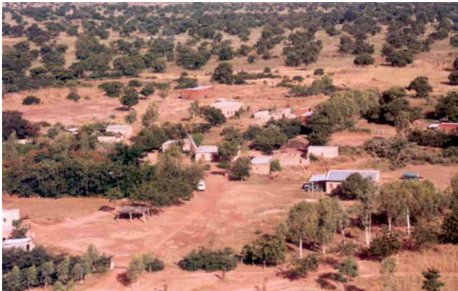
Vue aérienne du siège de l'AZN à Guiè (octobre 2003)
